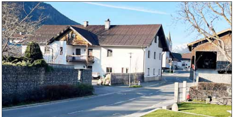
Das Gebäude Unterdorf 7 soll abgerissen und stattdessen ein Mehrfamilienwohnhaus errichtet werden. © Gemeinde Sistrans
